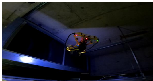
ドローン飛行による撮影状況（オフィス天井内）
