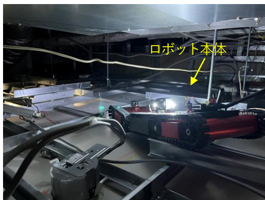
■ 天井内走行の様子（別カメラで撮影）
