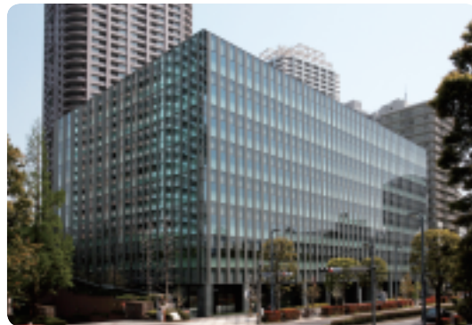
環境に配慮したリブダクト工法を採用
