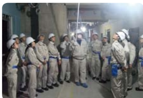
井田病院改築工事現場にて天井に収まる設備を見学
