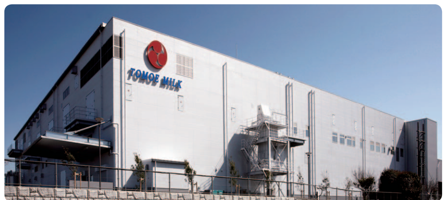
トモエ乳業(株)第二工場(茨城県)
