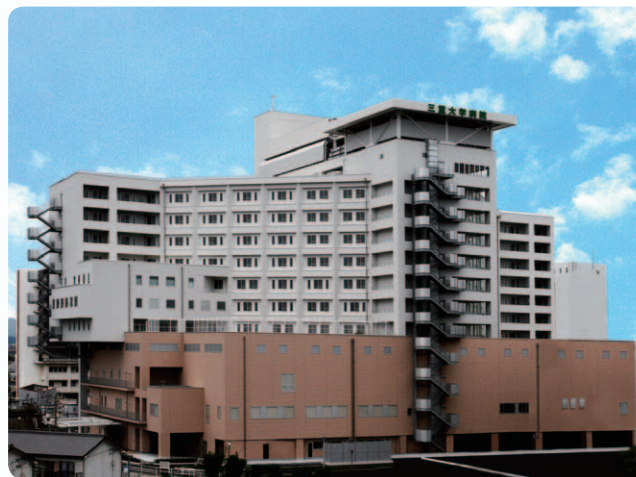
三重大学医学部附属病院病棟・診療棟(三重県)
