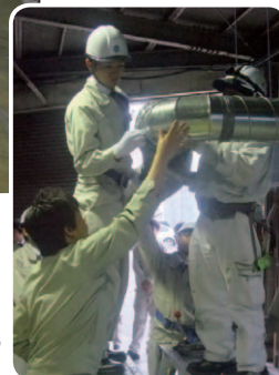
㈱協和工業埼玉工場で、ダクトの吊り込みを実際に体験
