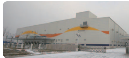
天津ユニ・チャーム 当社は空調・衛生・消火・集塵設備を施工
