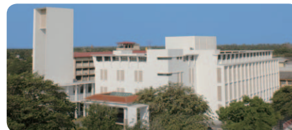
ジャフナ教育病院 当社は空調・衛生・消火設備を施工
