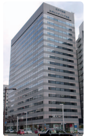
熱源最適制御などにより省CO 2 推進の名古屋駅前のランドマーク
