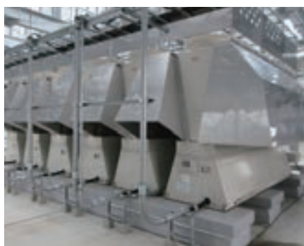
防雪フードと積雪対策基礎台
